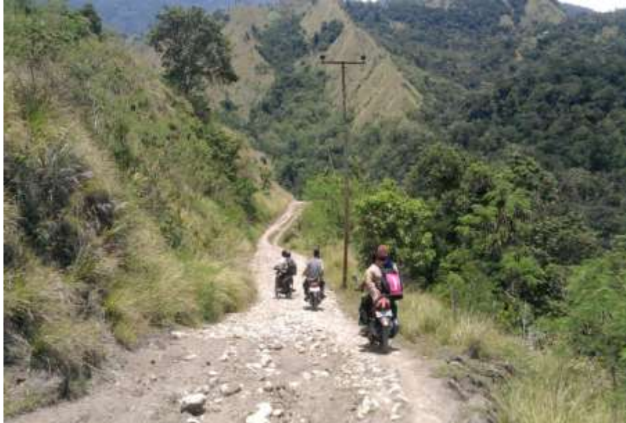
Foto 4.5. Jalan menuju tapak Tondon yang rusak dan tinggi (Sumber: Hasanuddin, 2011).
